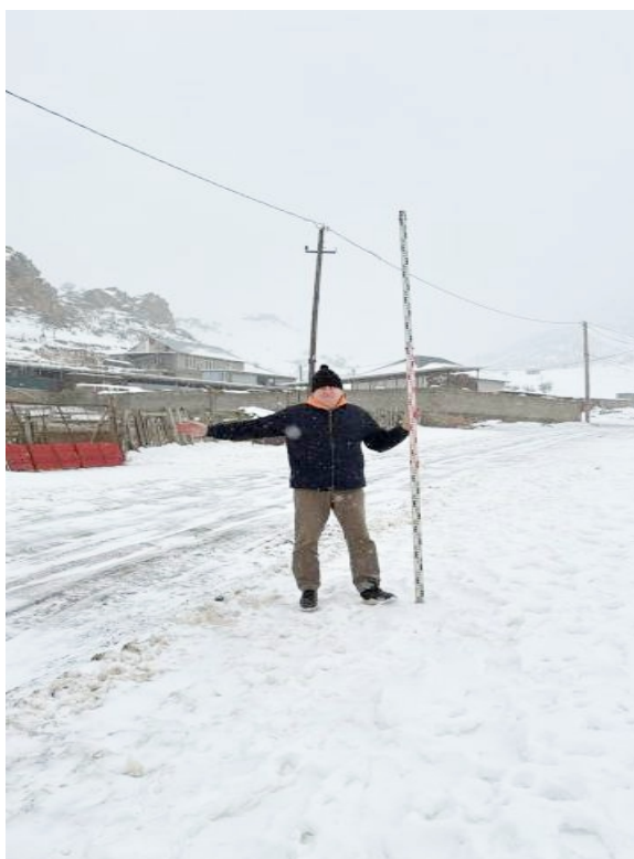
Илл. 20. Республика Дагестан, Кумторкалинский район. Земельный участок в рамках проекта «Проектирование и строительство магистрального водовода Чиркей - Махачкала - Каспийск, Республика Дагестан» 2. 2 этап «Строительство магистрального водовода от насосной станции III подъема (искл.) - до насосной станции IV подъема (вкл.)». Точка фотофиксации 12. Вид с юго-востока.
