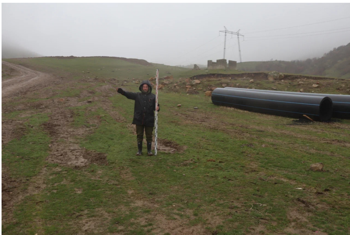
Илл. 14. Республика Дагестан, г.о. Махачкала. Земельный участок в рамках проекта «Проектирование и строительство магистрального водовода Чиркей - Махачкала - Каспийск, Республика Дагестан» 2. 2 этап «Строительство магистрального водовода от насосной станции III подъема (искл.) - до насосной станции IV подъема (вкл.)». Точка фотофиксации 8. Вид с запада.
