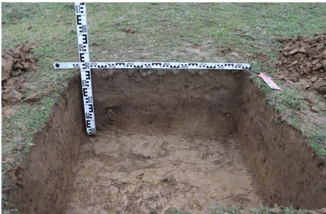
Илл. 43. Республика Дагестан, г.о. Махачкала. Земельный участок в рамках проекта «Проектирование и строительство магистрального водовода Чиркей - Махачкала - Каспийск, Республика Дагестан» 2. 2 этап «Строительство магистрального водовода от насосной станции III подъема (искл.) - до насосной станции IV подъема (вкл.)». Профиль северной стенки шурфа 3. Вид с юга.
