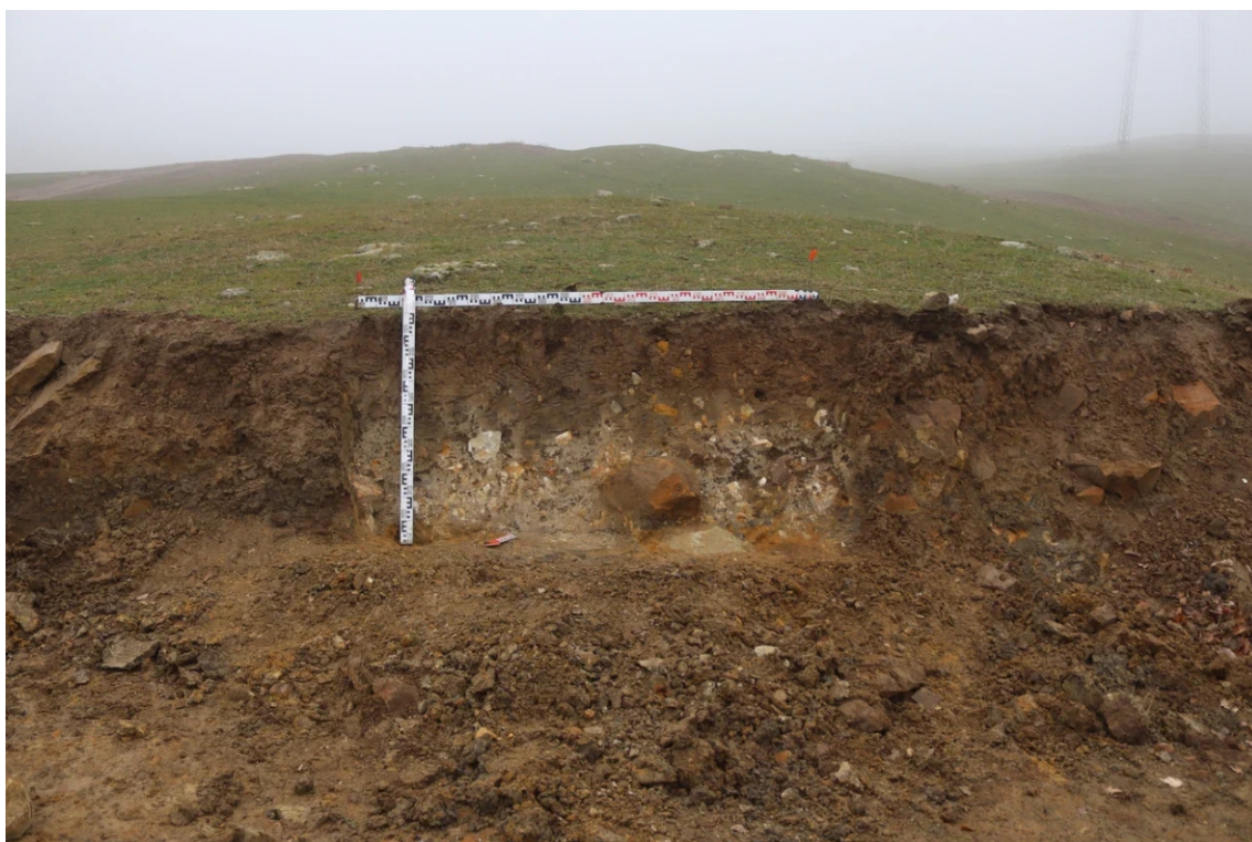
Илл. 38. Республика Дагестан, г.о. Махачкала. Земельный участок в рамках проекта «Проектирование и строительство магистрального водовода Чиркей - Махачкала - Каспийск, Республика Дагестан» 2. 2 этап «Строительство магистрального водовода от насосной станции III подъема (искл.) - до насосной станции IV подъема (вкл.)». Профиль зачистки 1. Вид с северо-запада.
