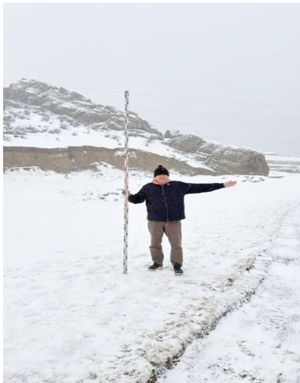
Илл. 19. Республика Дагестан, г.о. Махачкала. Земельный участок в рамках проекта «Проектирование и строительство магистрального водовода Чиркей - Махачкала - Каспийск, Республика Дагестан» 2. 2 этап «Строительство магистрального водовода от насосной станции III подъема (искл.) - до насосной станции IV подъема (вкл.)». Точка фотофиксации 12. Вид с северо-запада.
