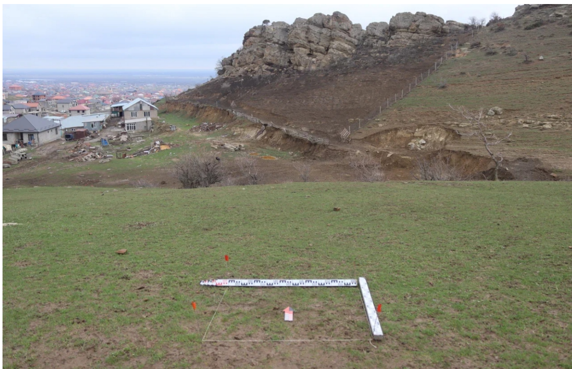
Илл. 29. Республика Дагестан, г.о. Махачкала. Земельный участок в рамках проекта «Проектирование и строительство магистрального водовода Чиркей - Махачкала - Каспийск, Республика Дагестан» 2. 2 этап «Строительство магистрального водовода от насосной станции III подъема (искл.) - до насосной станции IV подъема (вкл.)». Место заложения шурфа 1. Вид с юга.
