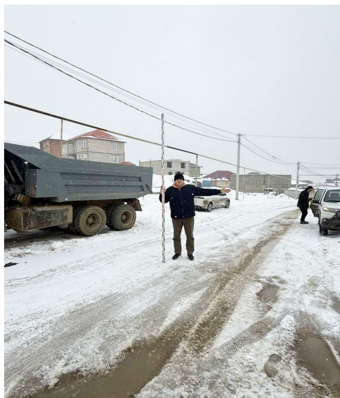
Илл. 24. Республика Дагестан, Кумторкалинский район. Земельный участок в рамках проекта «Проектирование и строительство магистрального водовода Чиркей - Махачкала - Каспийск, Республика Дагестан» 2. 2 этап «Строительство магистрального водовода от насосной станции III подъема (искл.) - до насосной станции IV подъема (вкл.)». Точка фотофиксации 14. Вид с юго-востока.
