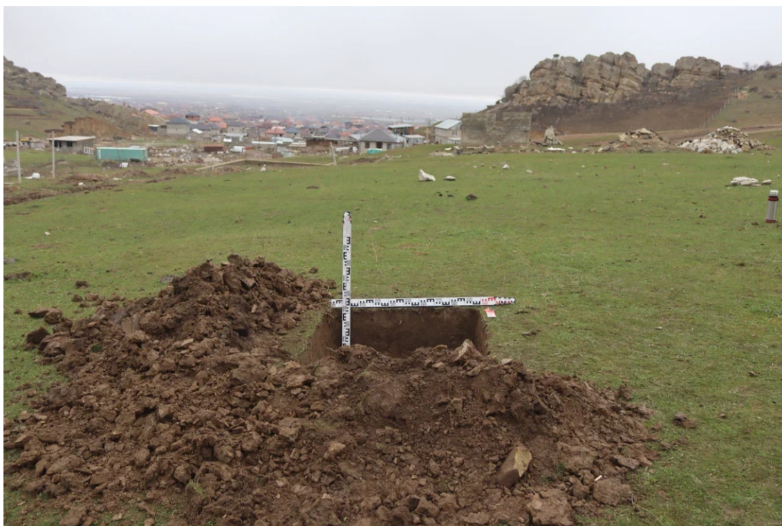
Илл. 34. Республика Дагестан, г.о. Махачкала. Земельный участок в рамках проекта «Проектирование и строительство магистрального водовода Чиркей - Махачкала - Каспийск, Республика Дагестан» 2. 2 этап «Строительство магистрального водовода от насосной станции III подъема (искл.) - до насосной станции IV подъема (вкл.)». Шурф 2 в рельефе местности. Вид с юга.
