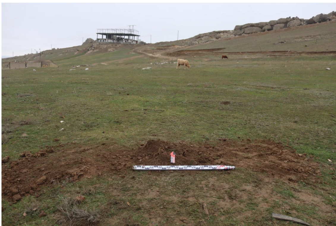
Илл. 44. Республика Дагестан, г.о. Махачкала. Земельный участок в рамках проекта «Проектирование и строительство магистрального водовода Чиркей - Махачкала - Каспийск, Республика Дагестан» 2. 2 этап «Строительство магистрального водовода от насосной станции III подъема (искл.) - до насосной станции IV подъема (вкл.)». Поверхность шурфа 3 после засыпки. Вид с юга.
